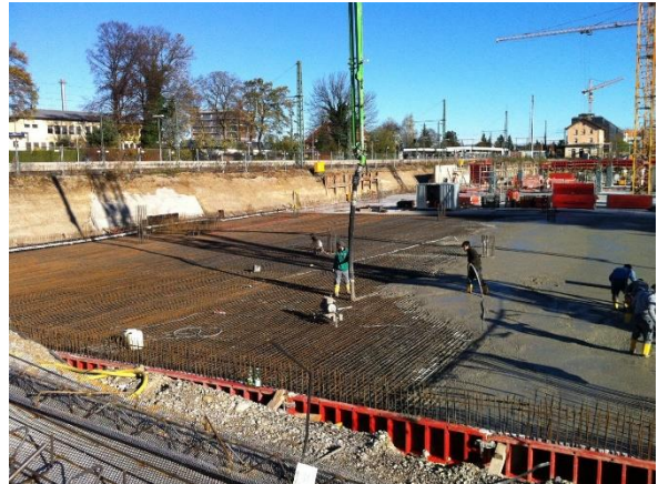
Abbildung 4: Betonage Bodenplatte mit Pumpe
