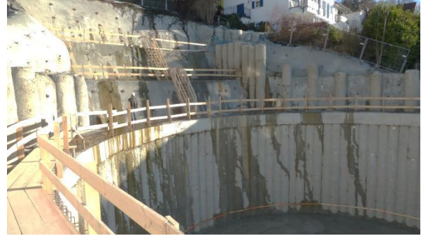
Abb. 3: Bohrfahrling und Nagelwände
