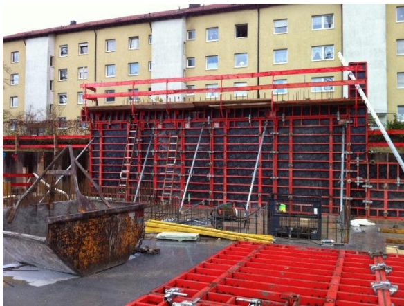
Abbildung 3: Schalung Wand 2
