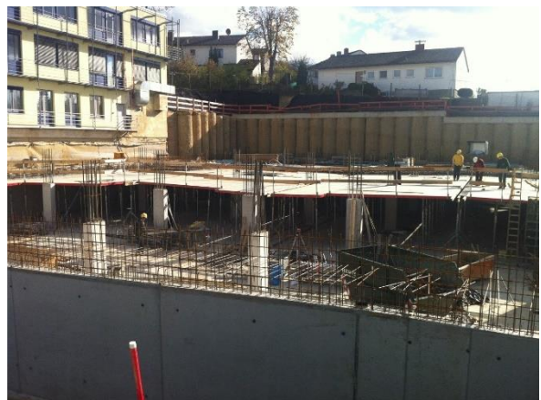
Abbildung 5: Deckentische für UG 2.1 Takt 4 mit erkennbarem Entwässerungsgefälle
