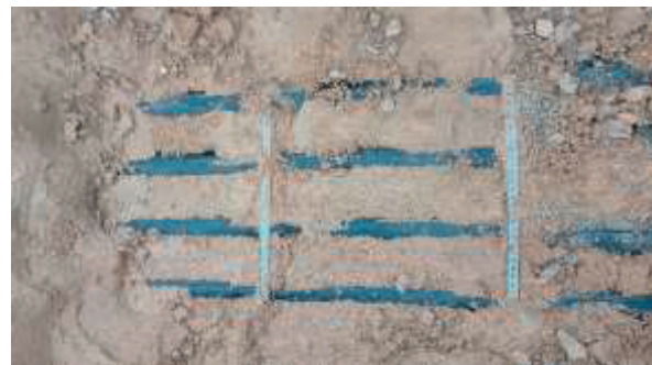
Abb. 3: Lagenweise Ausbau Flüssigboden mittels Saugbagger
