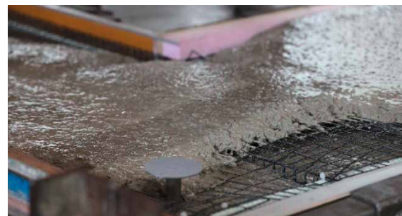
Abb. 3: Wandquerschnitt während der Betonage (Bildquelle: Firma EUDUR)
