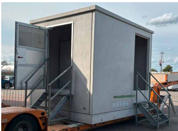
Abb. 1: Prototyp des gebauten Transformatorengebäudes „EcoCube“ (Bildquelle: Firma EUDUR)
