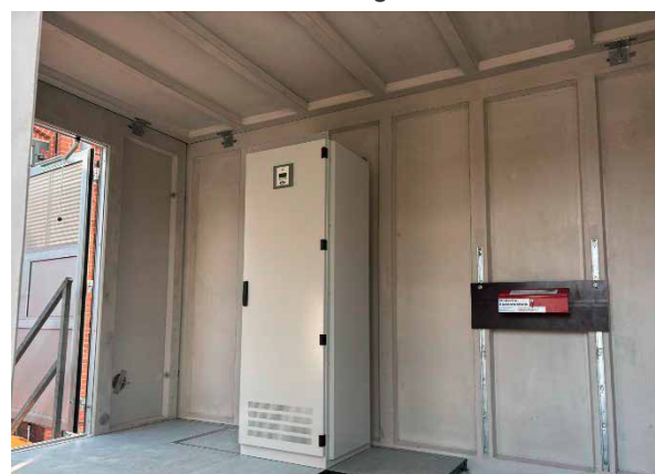
Abb. 2: Transformatorengebäude mit Plattenbalkenquerschnitt (Bildquelle: Firma EUDUR)
