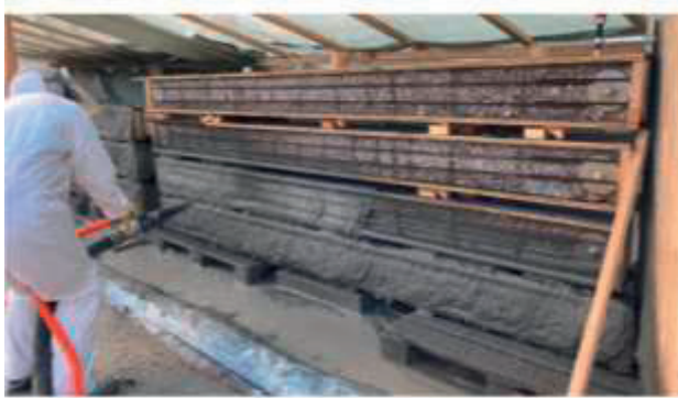
Abb. 1: UHFSB Spritzbetonage durch fachkundiges Personal
