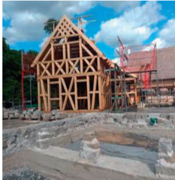
Abb. 1: Forschungsbaustelle Naturdorf Bärnau
